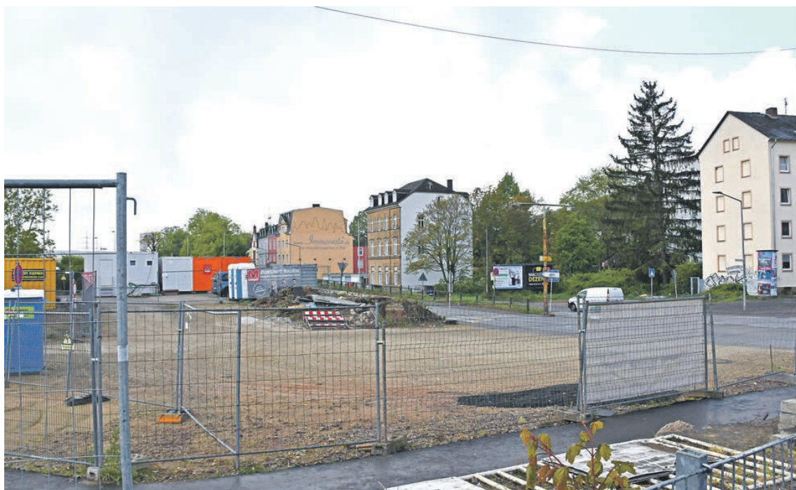
Kreuzung. An der Einmündung der neuen Straße Über Brücken in die Hornstraße (rechts) soll in den kommenden Monaten ein Kreisverkehr entstehen. Auch die Markusstraße und die Rampe zur Bahnüberführung führen zu dem Knotenpunkt. Foto: Presseamt/jw
