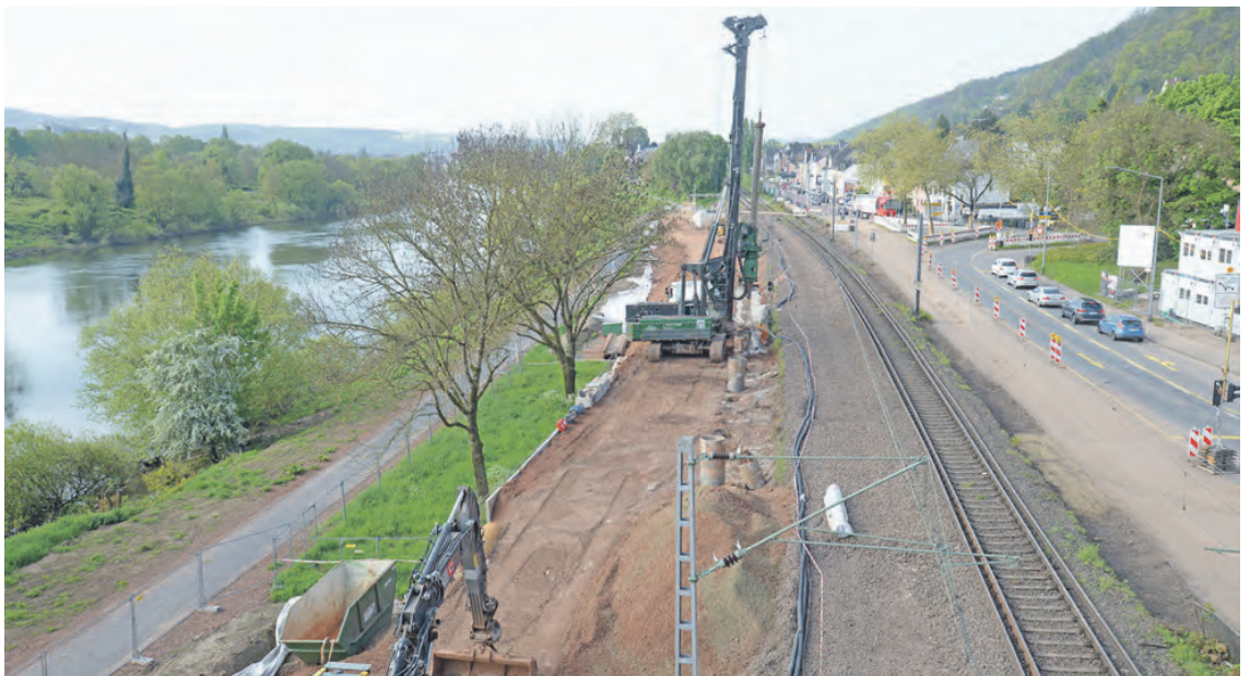
Schwer was los. Mit einem Pfahlbohrgerät werden am künftigen Haltepunkt Pallien die Tiefgründungen für einen der 170 Meter langen Bahnsteige verankert. Links verläuft die provisorische Trasse des Moselradwegs. Foto: PA/kg
